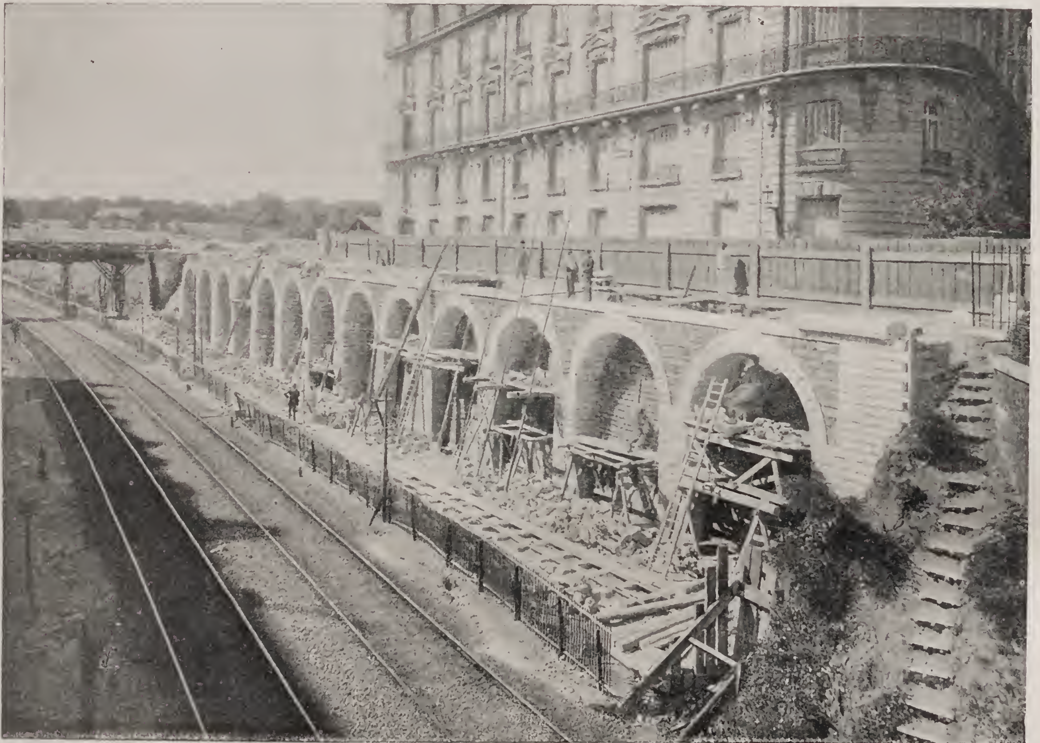
LA LIGNE COURCELLES-CHAMP-DE-MARS. — Mur de soutènement, à arcades, du boulevard Jules-Sandeau.
